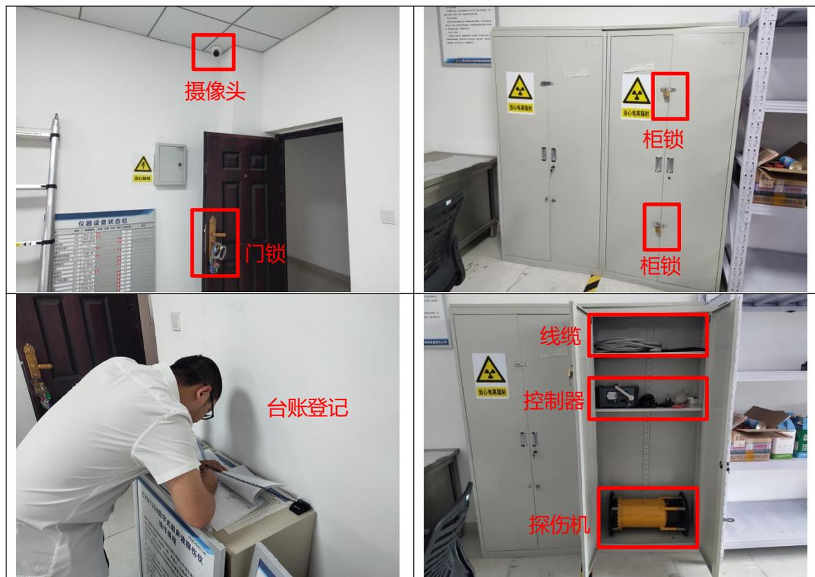
图 2-1 桥梁设备室防盗防破坏措施
