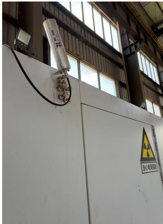
固定式场所辐射探测报警装置
